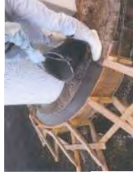
亀裂補修(環状遮断)
